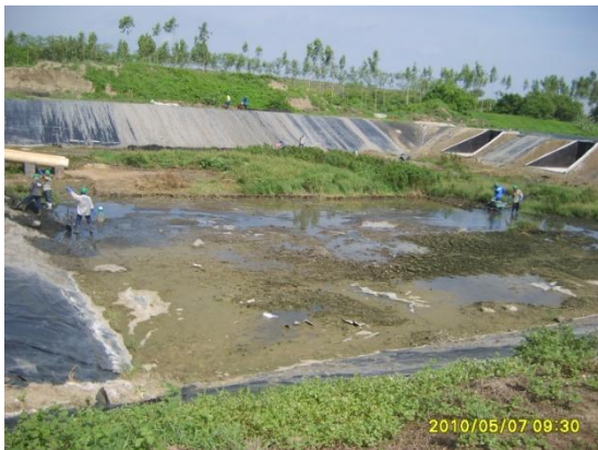
Foto No. 1. Trabajos de optimización del módulo No. 1 de la EDAR Galapa.
