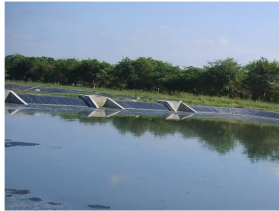
Foto No. 2. Módulo No. 2 de la EDAR Galapa en operación.
