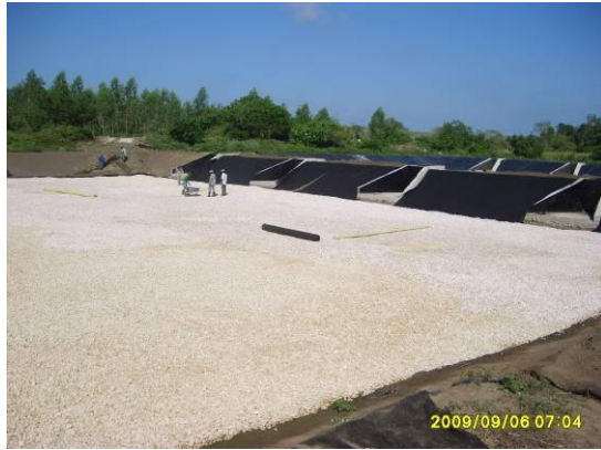
Foto No. 1. Proceso constructivo Módulo No. 2 EDAR Galapa.
